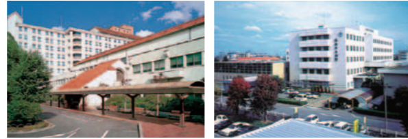
倉敷中央病院 西条中央病院
